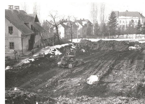
Slika 3: Pričetki gradnje nove šole na Jesenicah
